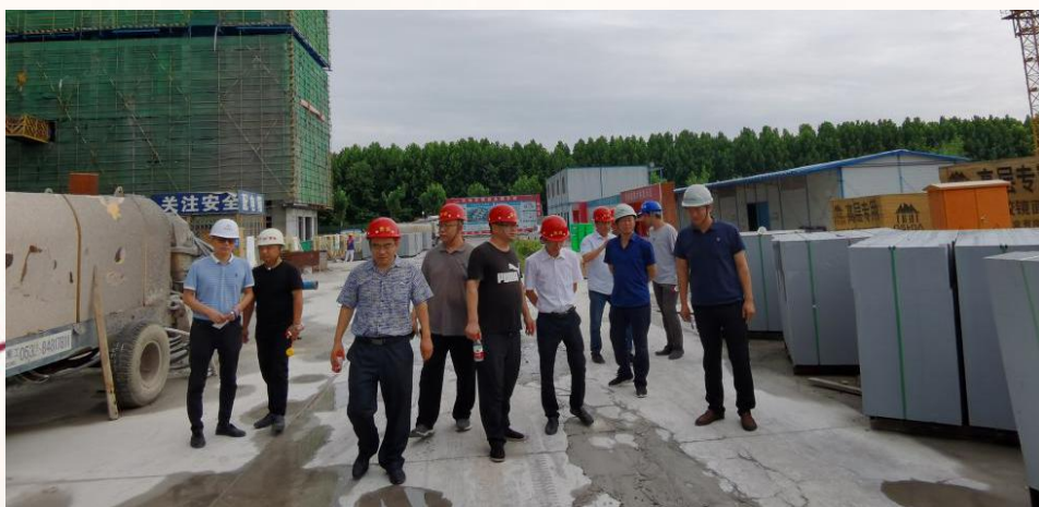
检查工地施工安全
